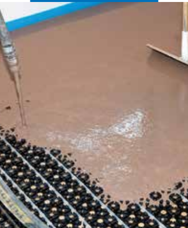
A Novoplan Maxi szivattyúzása és kiegyenlítése
