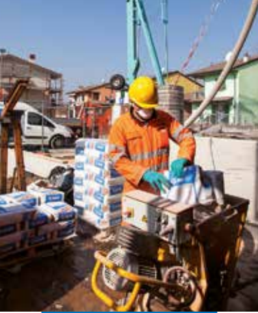
A Novoplan Maxi előkészítése és szivattyúzása folyamatos keverésű szivattyúval
